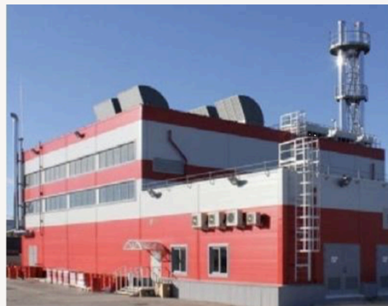
Энергоцентр для распределительного центра АО «Тандер», г. Дзержинск Электрическая мощность 4 МВт
